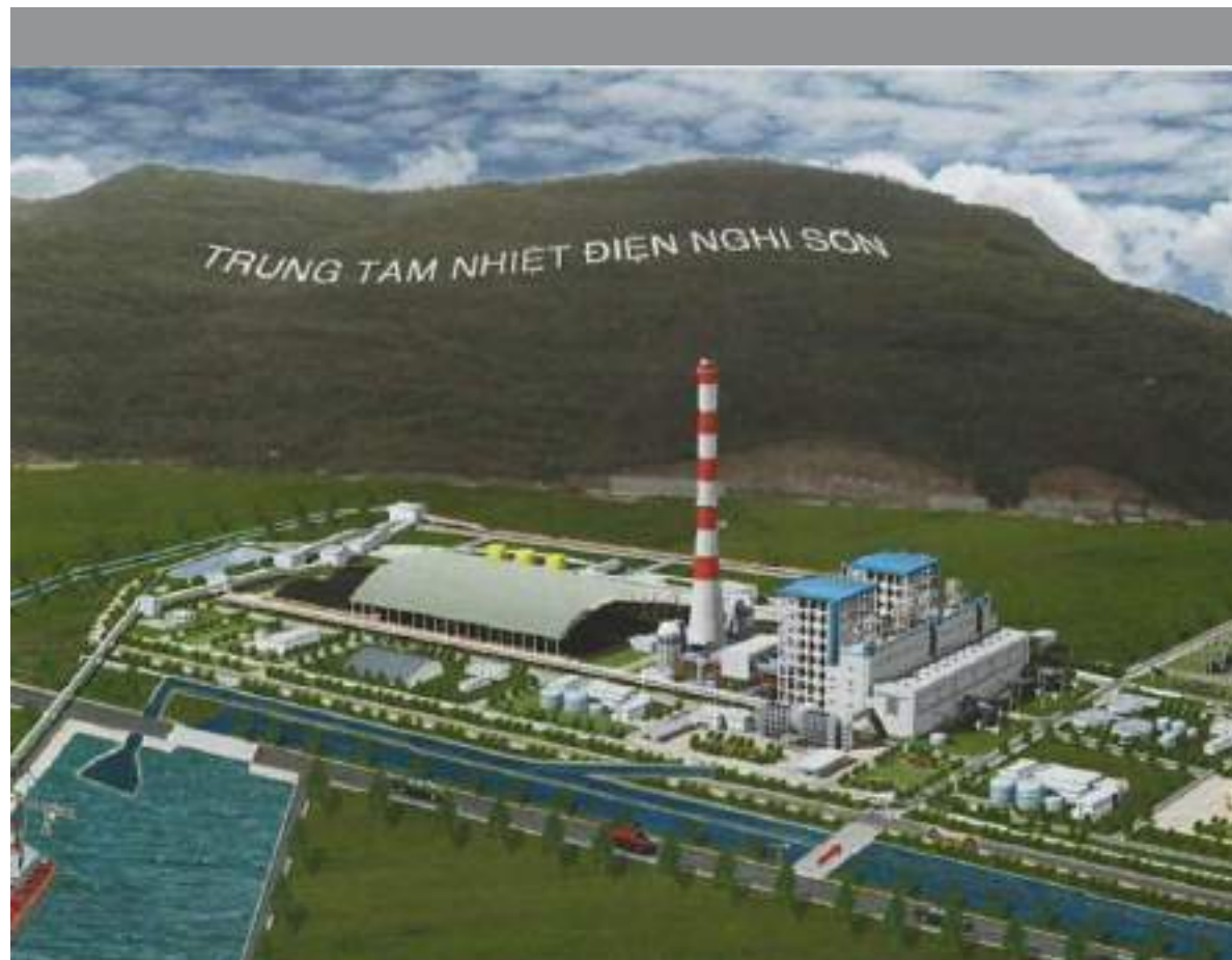
Nhà máy Nhiệt điện Nghi Sơn 1
