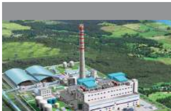
Nhà máy Nhiệt điện Thái Bình 1
