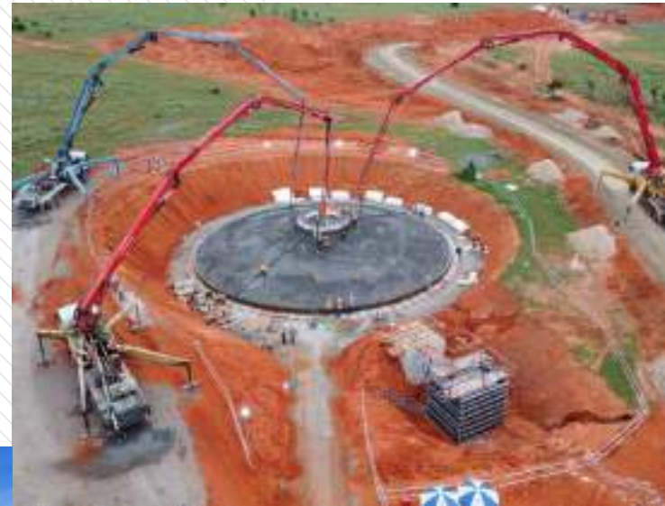
Dự án Nhà máy Điện gió Thái Hòa - Bình Thuận
