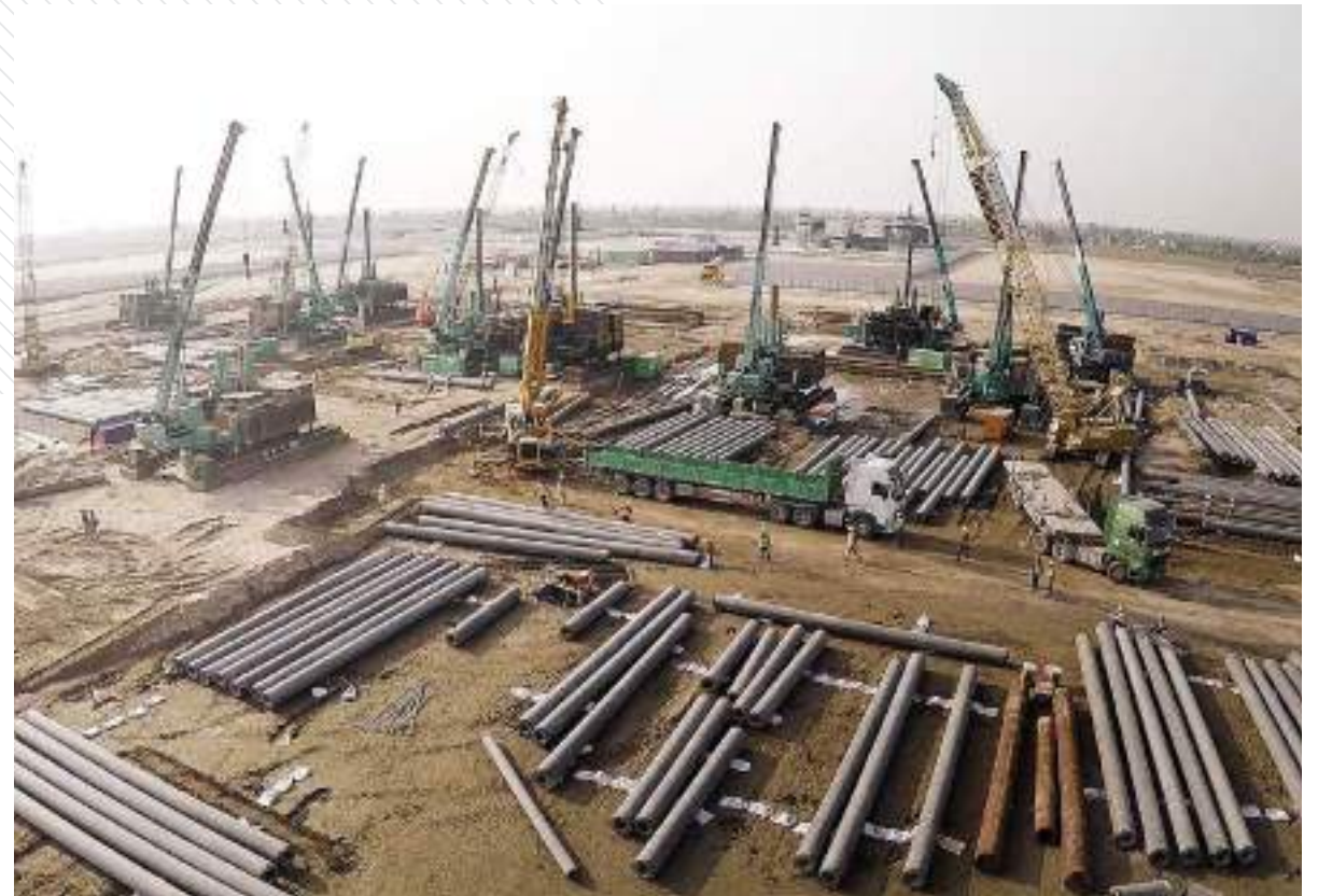
Thi công cọc tại dự án Nhiệt điện Thái Bình
