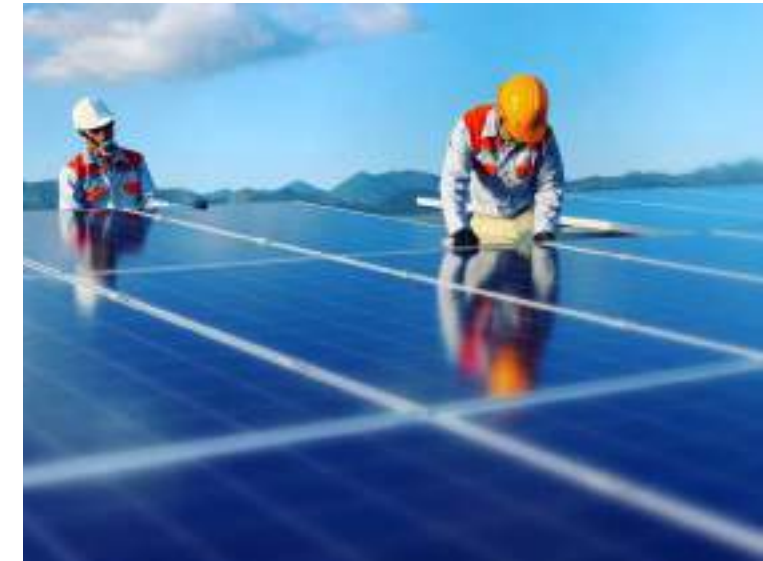
Nhà máy Điện mặt trời Vĩnh Hào 6
