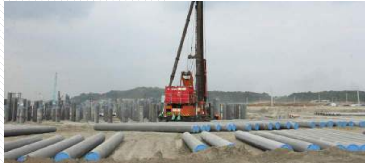
Thi công cọc tại dự án lọc hóa dầu Long Sơn
