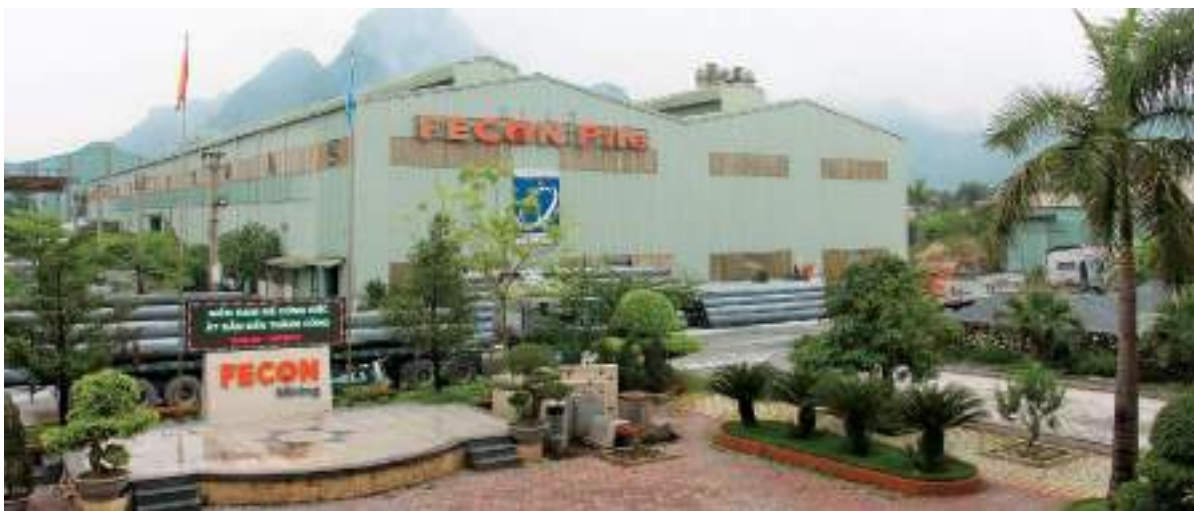
Nhà máy FECON Pile tại Hà Nam
