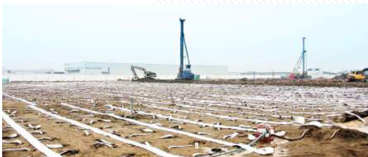
Nhà máy LG Hải Phòng - Xử lý nền bằng phương pháp thi công bắc thấm và cọc xi măng đất:
