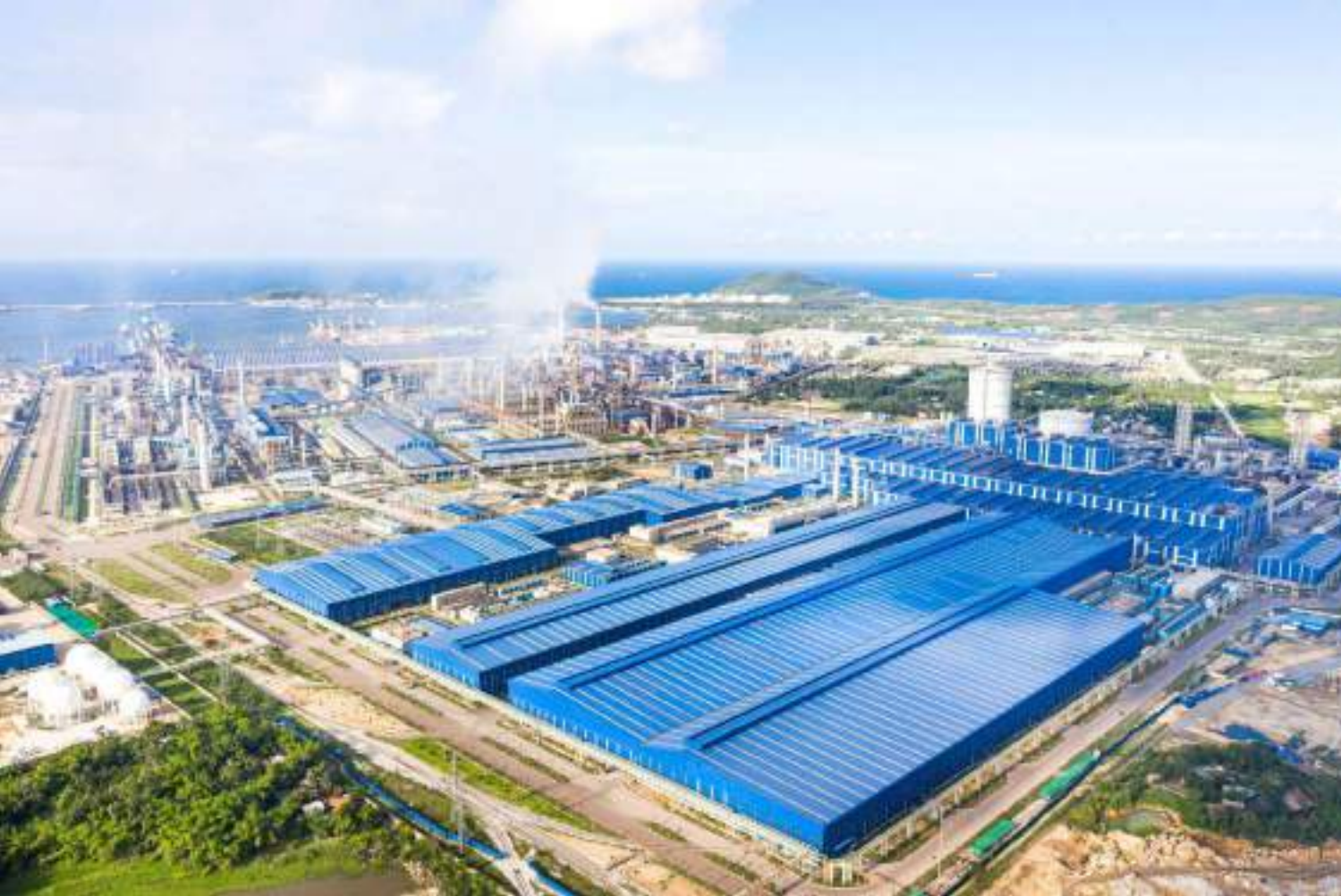
Dự án Nhà máy thép Hòa Phát - Dung Quất
