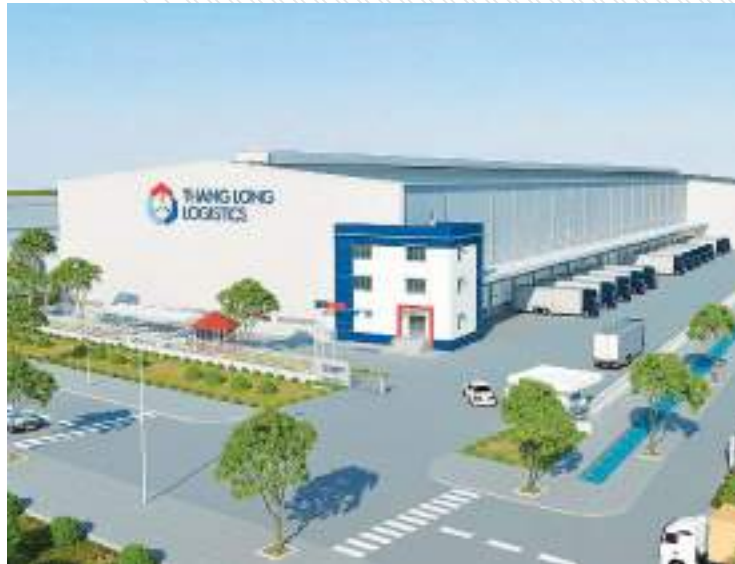
Trung tâm Logistics Thăng Long (Hưng Yên) - Tổng thầu hạng mục xây dựng kết cấu, hạ tầng, hoàn thiện và M&E
