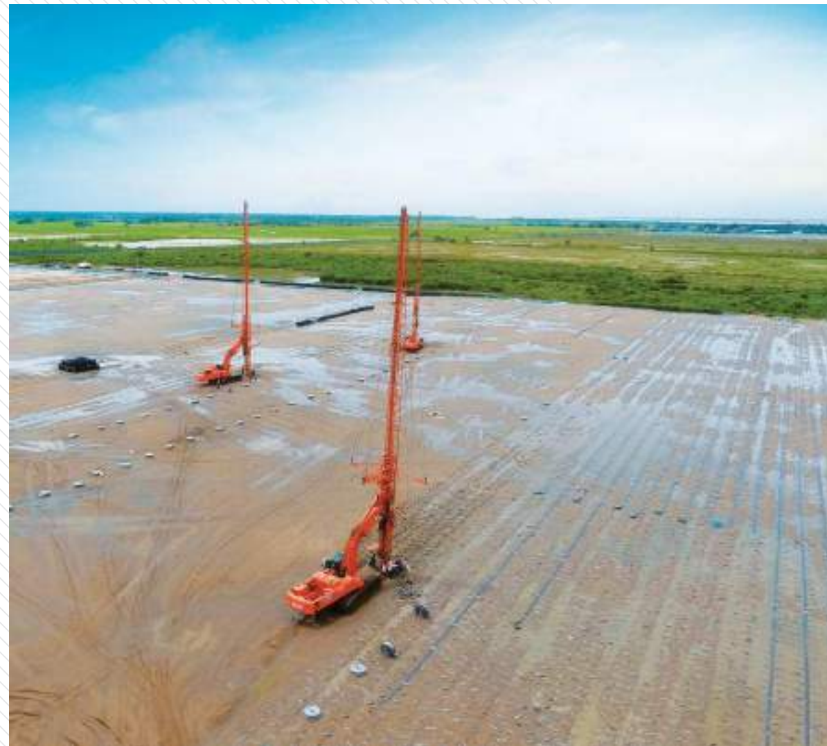
Cảng Thilawa (Myanmar) - Xử lý nền bằng phương pháp bắc thấm
