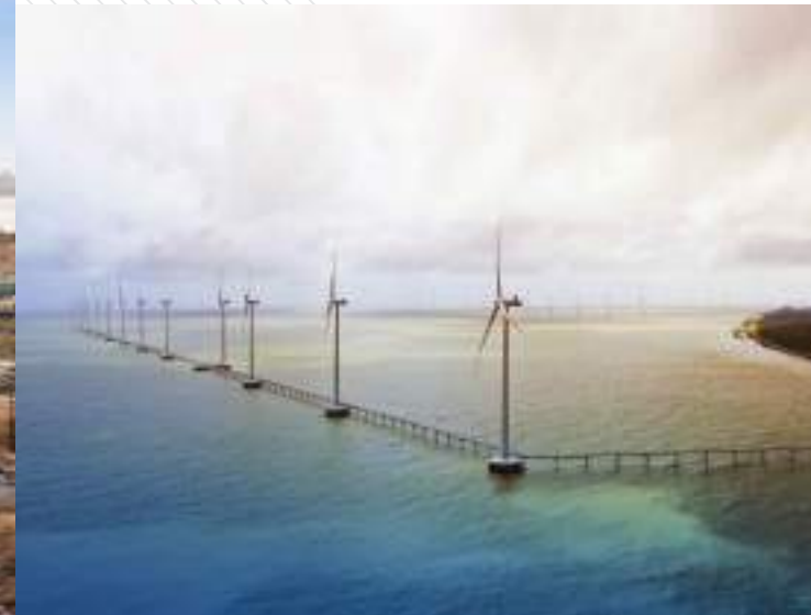
Dự án Nhà máy điện gió Trà Vinh V1.3
