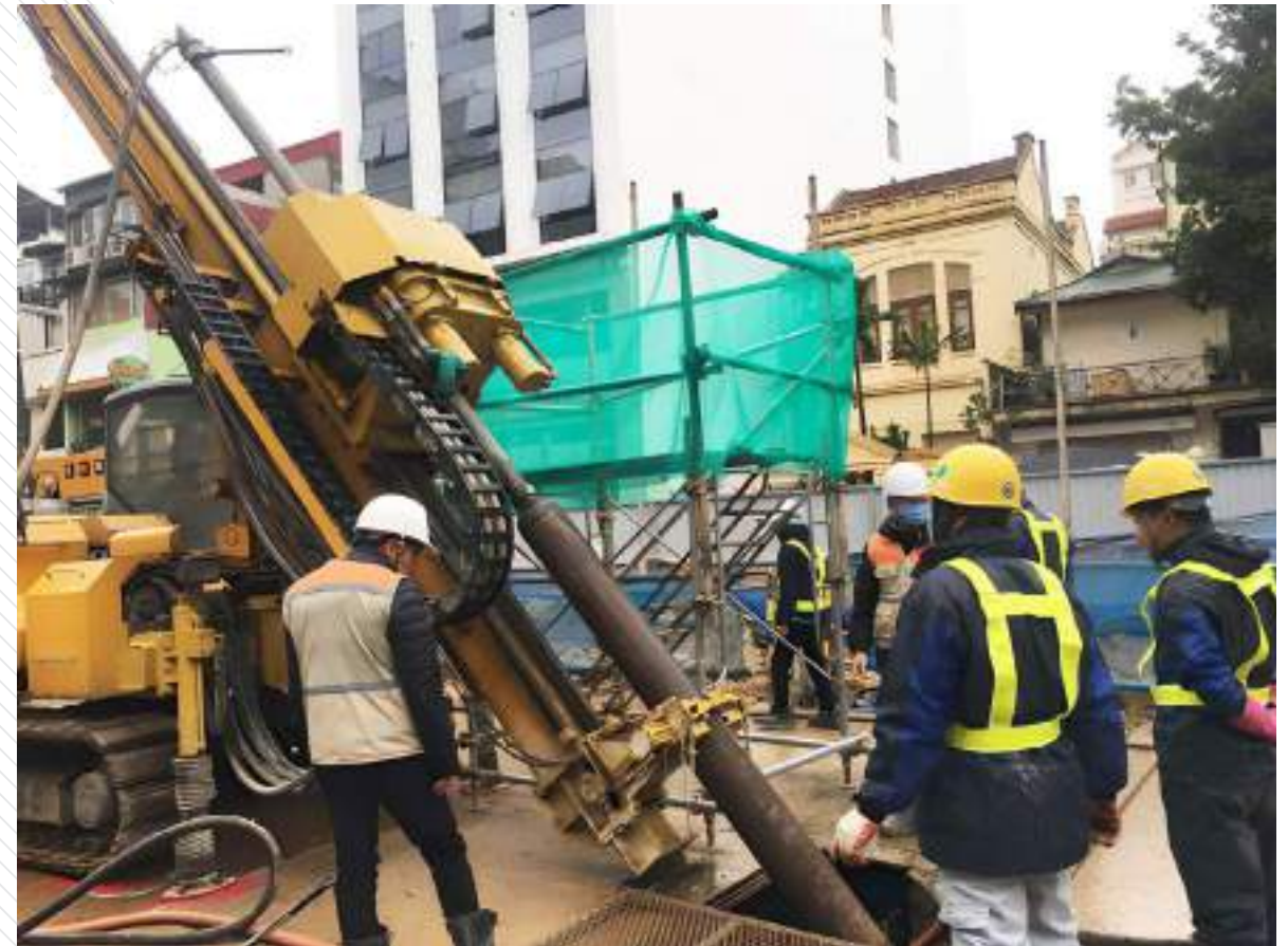
3 Ảnh 3. Metro Line 3 (TP. Hà Nội) Công nghệ Jet Grouting
