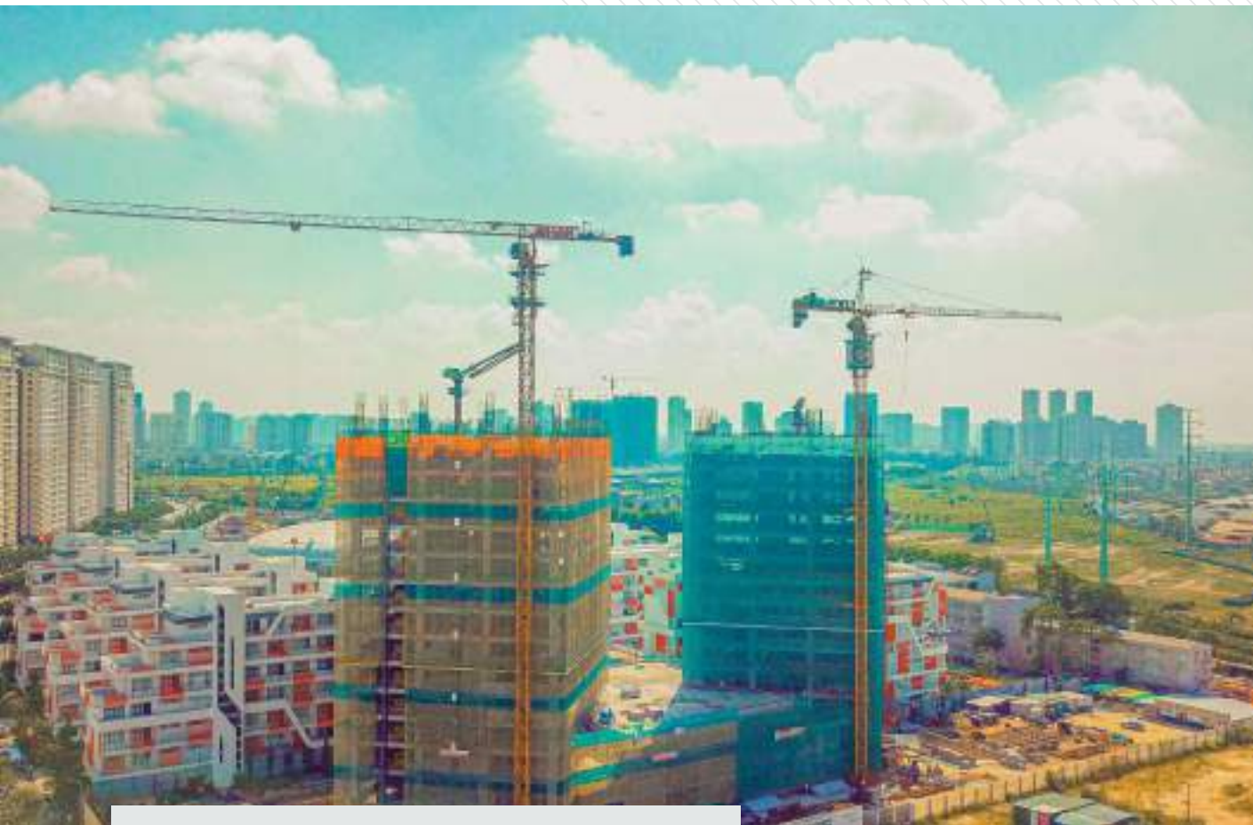
Đại học Phenikaa - Tổng thầu xây dựng kết cấu - hoàn thiện, M&E
