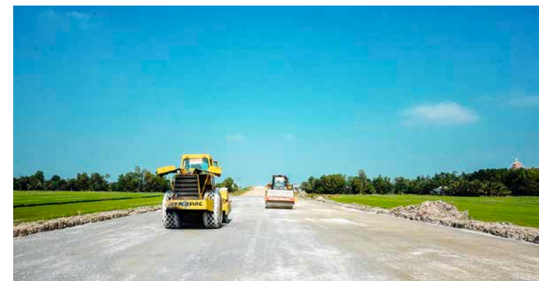
Tuyến Lộ Tẻ - Rạch Sỏi - Thi công nền đường
