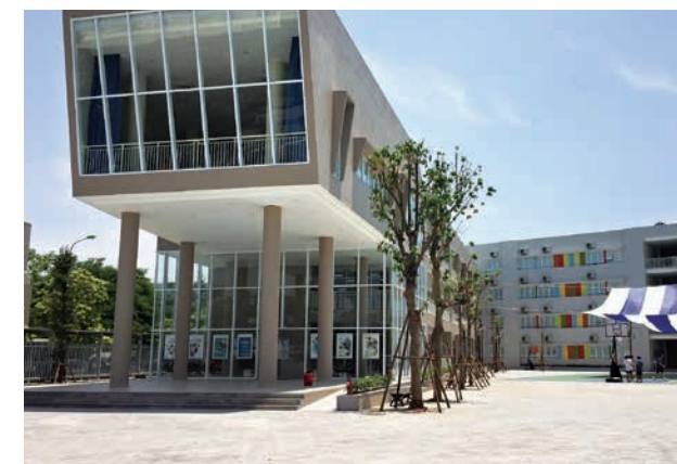
Trường Wellspring - Tổng thầu xây dựng, kết cấu, hoàn thiện và M&E
