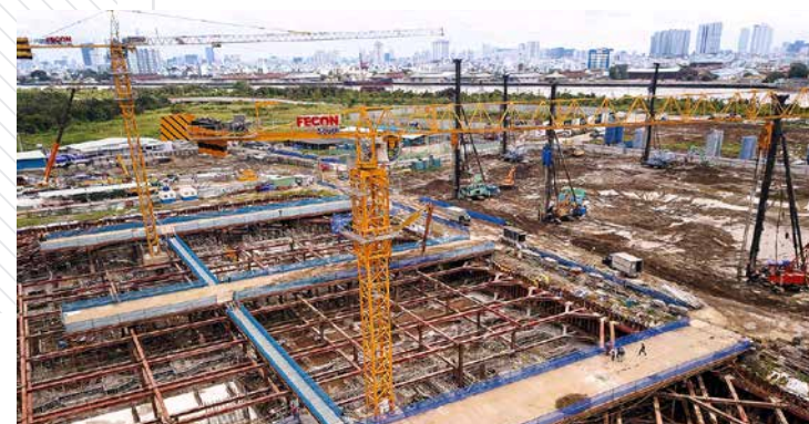
Empire City - Kết cấu tầng hầm
