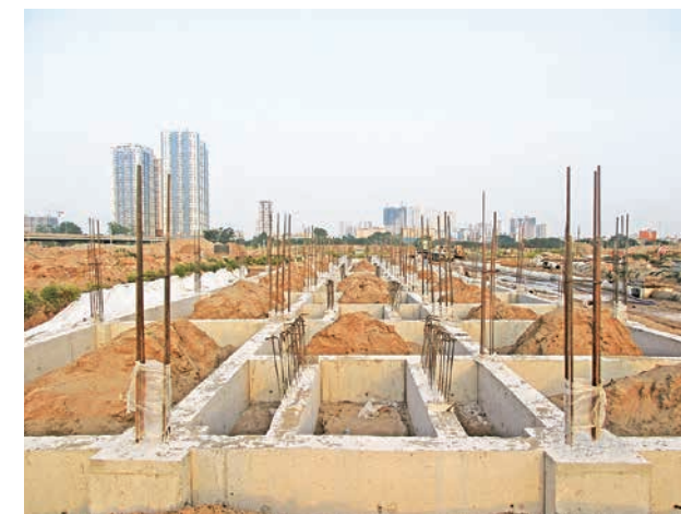
Manor Central Park (Hà Nội) - Thi công kết cấu móng và hầm
