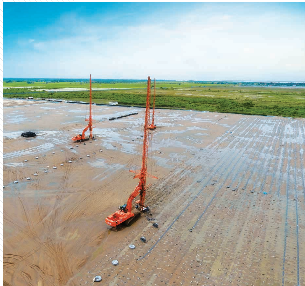
Cảng Thilawa (Myanmar) - Xử lý nền bằng phương pháp bắc thấm
