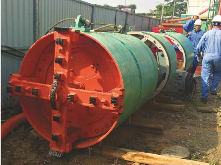
Gói thầu G - Dự án cải thiện môi trường nước TPHCM Thi công pipe jacking
