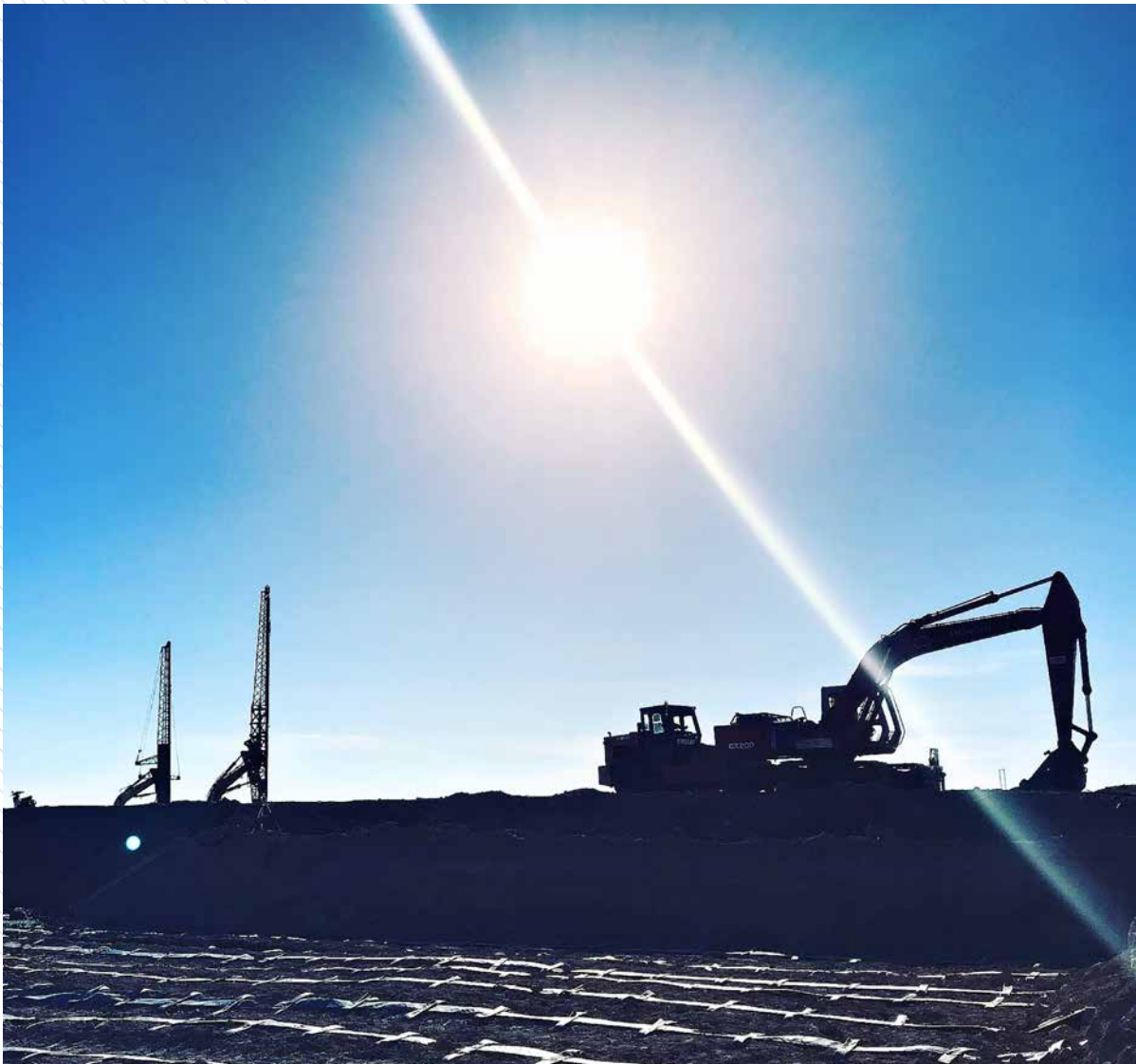
Tổ hợp hóa dầu Long Sơn (Bà Rịa, Vũng Tàu) - Xử lý nền bằng bắc thấm và kết hợp gia tải hút chân không, thi công đầm động
