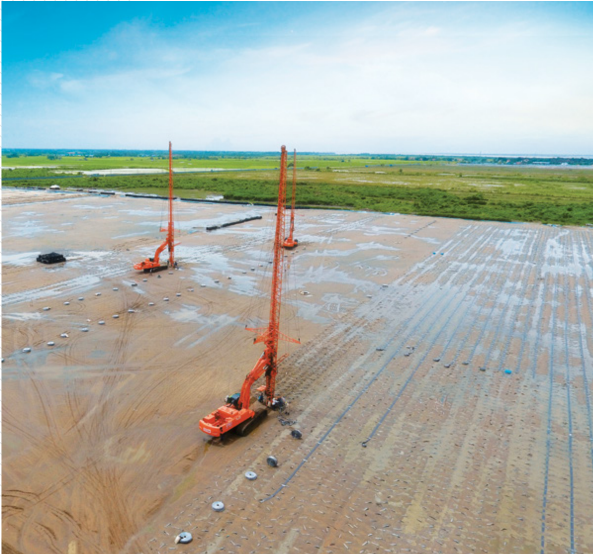
Cảng Thilawa (Myanma) - Xử lý nền bằng phương pháp bắc thấm
