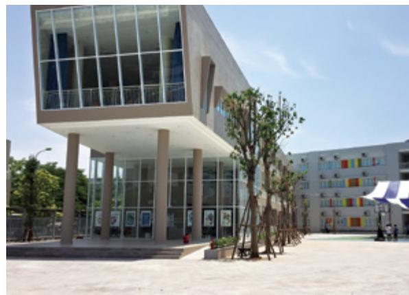
Trường Wellspring - Tổng thầu xây dựng, kết cấu, hoàn thiện và M&E
