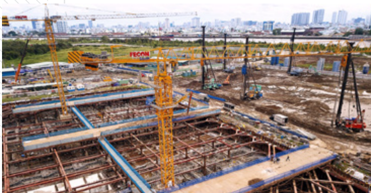
Empire City - Kết cấu tầng hầm
