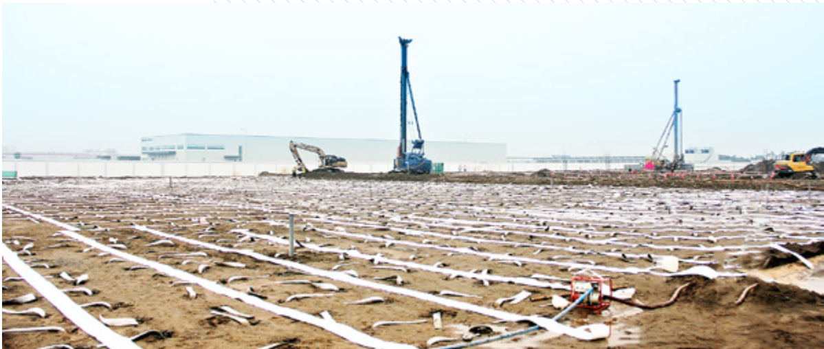
Nhà máy LG Hải Phòng - Xử lý nền bằng phương pháp thi công bắc thấm và cọc xi măng đất: 50.234m
