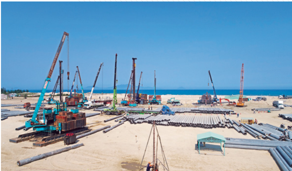
Hoiana (Nam Hội An) – Khu Phức hợp nghỉ dưỡng, Casino, Sân golf Cung cấp, thi công cọc PHC D350, D500, khoan dẫn
