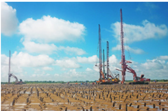
Cảng Thilawa (Myanma) - Xử lý nền bằng phương pháp bắc thấm
