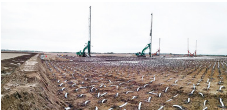
Tổ hợp hóa dầu Long Sơn (Bà Rịa, Vũng Tàu) - Xử lý nền bằng bắc thấm và kết hợp gia tải hút chân không, thi công đầm động
