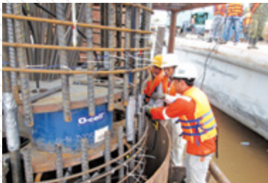
Cầu Cao Lãnh - Thí nghiệm nén tĩnh bằng phương pháp O-Cell (đường kính 2500mm)
