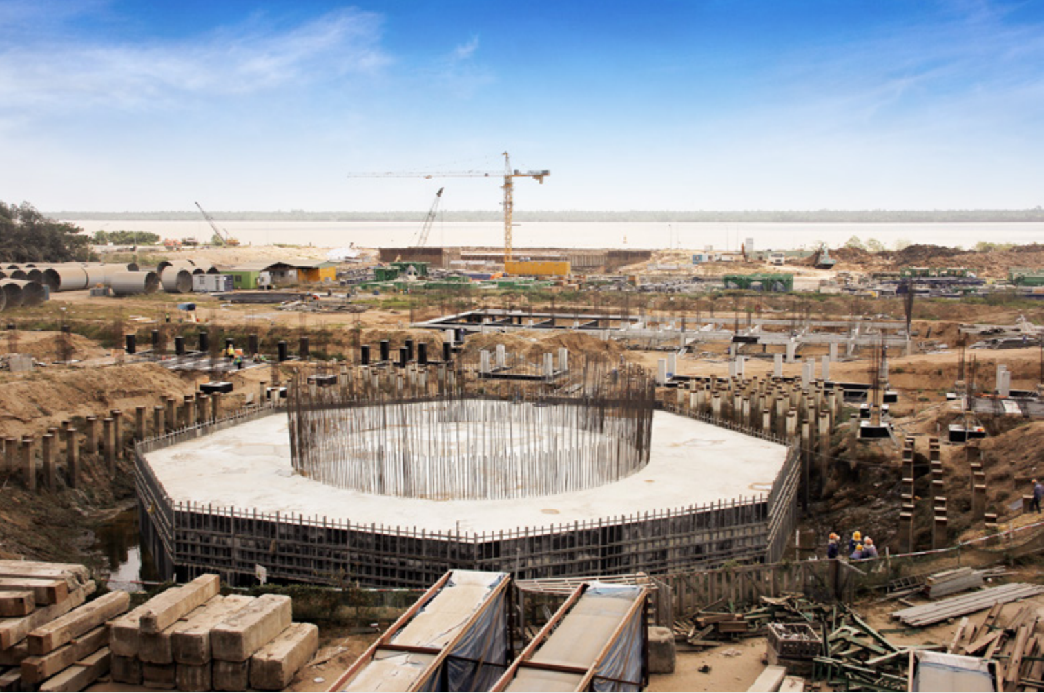
Nhà máy nhiệt điện Long Phú 1 - Thấu chính hạng mục kết cấu móng ống khói
