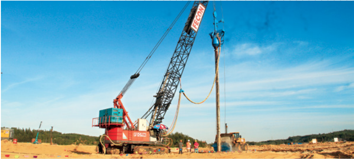
Nhà máy thép Hòa Phát Dung Quất (Quảng Ngãi) - Thi công đầm rung sâu
