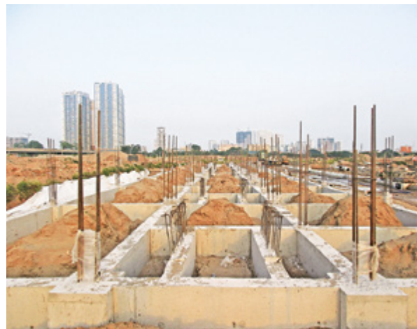
Manor Central Park (Hà Nội) - Thi công kết cấu móng và hầm
