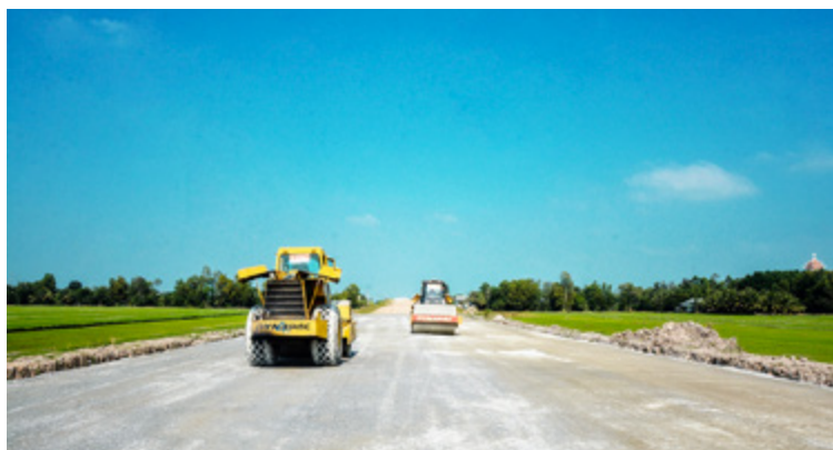
Tuyến Lộ Tẻ - Rạch Sỏi - Thi công nền đường
